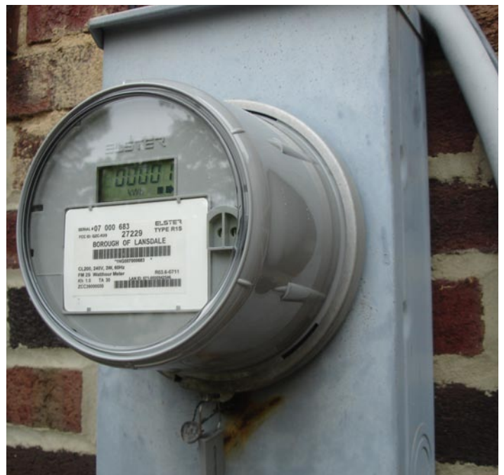
Een smart meter ofwel slimme meter is een digitale elektriciteitsmeter die de analoge draaistroommeter vervangt. Hij kan op afstand worden uitgelezen en bediend.
